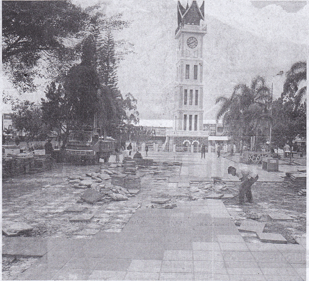
REVITALISASI — Revitalisasi kawasan pedestrian Jam Gadang mulai dikerjakan. Terlihat pekerja tengah membongkar lantai yang terbuat dari batu alam di kawasan tersebut Selasa (17/7). GATOT
