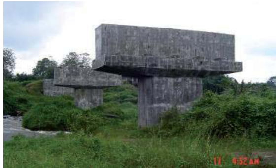
Gambar : Jembatan Way Curup tidak sesuai spesifikasi
